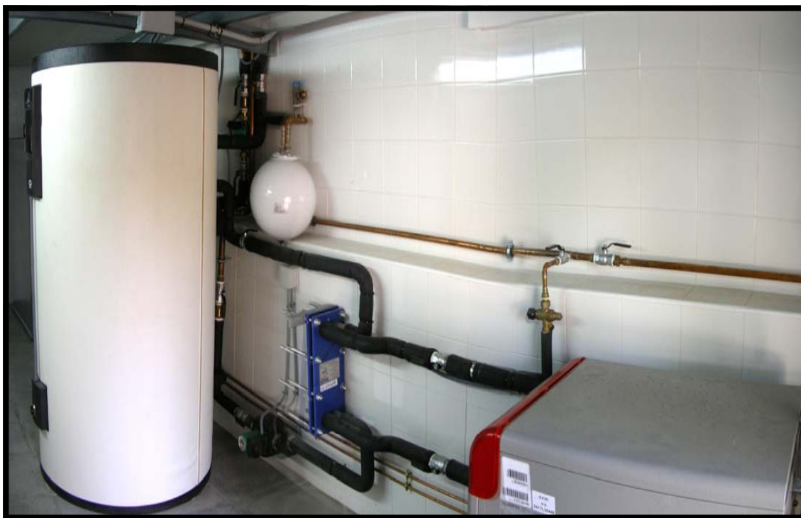
Sistema de Agua Caliente Sanitaria (ACS) Instalación en tubería Diam. 40mm (aislada)
